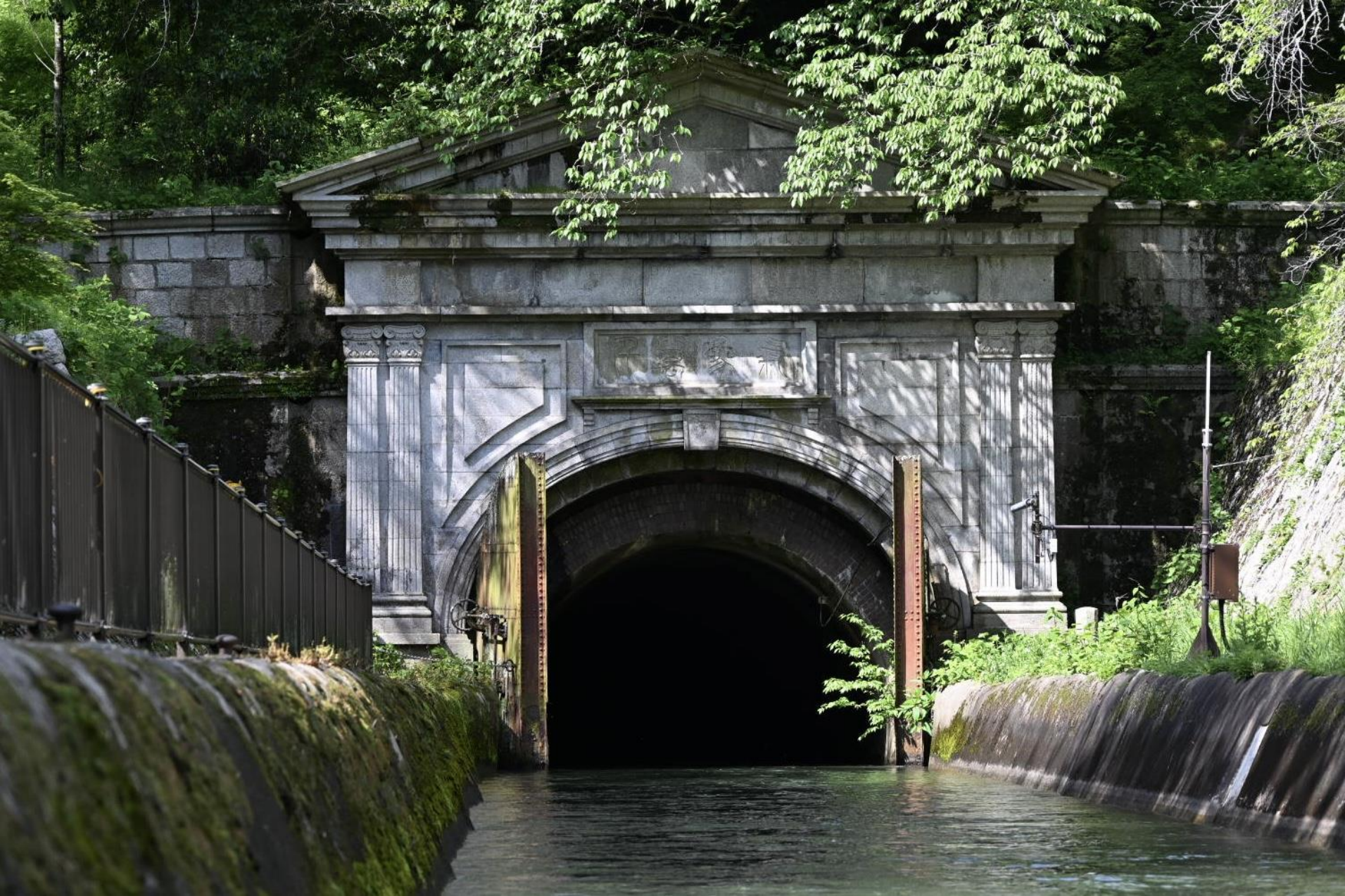
【国宝】第一隧道（東坑門）
