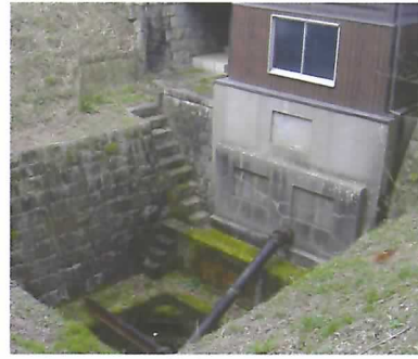
日本で最初の蒸気機関動力ポンプによる灌漑揚水場 ③ 龍ヶ池 MAP K-6
