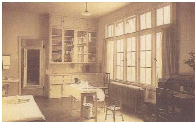
開設当時、スチーム暖房が設置された 2 階保健室
