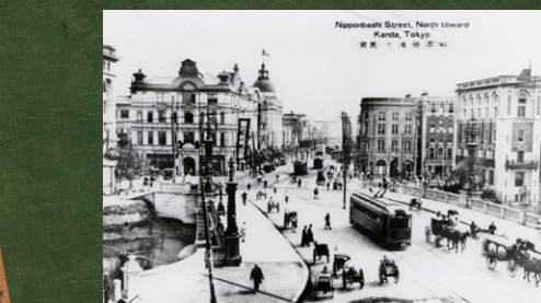
1923(大正12)年、完成したばかりの東京店(左奥)。関東大震災により大被害を受けた 写真：西川株式会社
