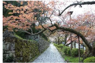
穴太衆積みの石垣
